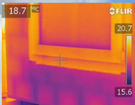
Prova termica: foto in termocamera
